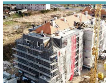
Budynek komunalny w budowie - ul. Leśna
