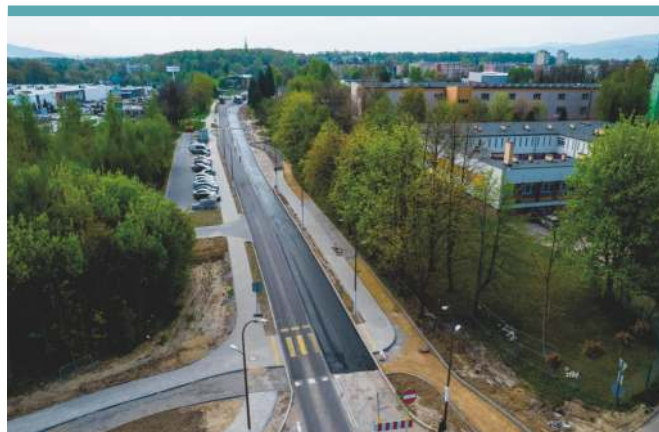
Wyremontowana ul. gen. W. Sikorskiego
