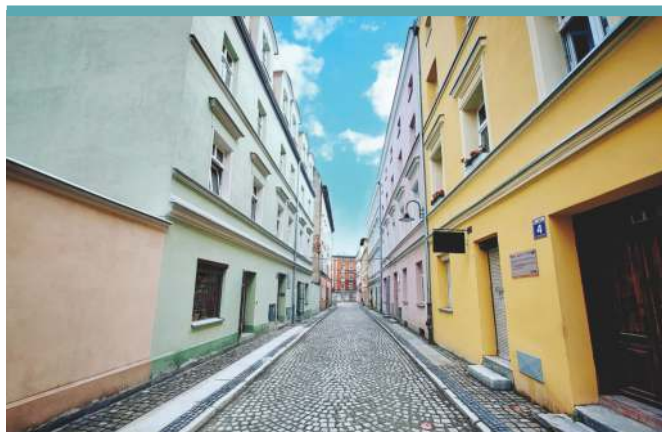
Wyremontowana ul. Przechodnia
